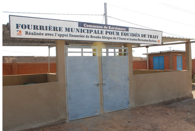
Fourrière pour équidé de trait construite au sein de la Mairie de Korsimoro avec l'appui d'Inades-Formation et Brooke Afrique de l'Ouest
